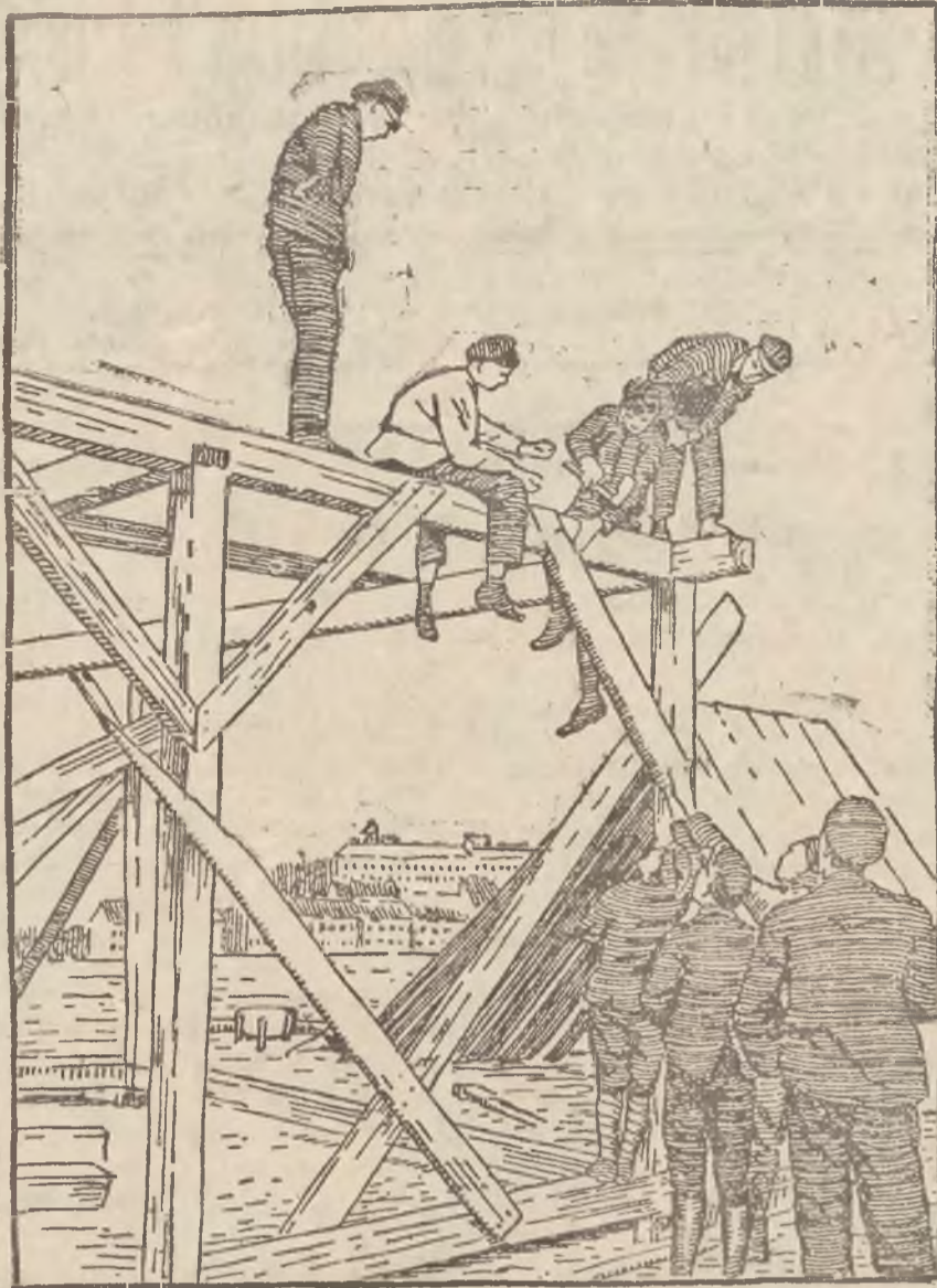
TECHNICZY PRZY BUDOWIE WŁASNEGO DOMU WE LWOWIE.
