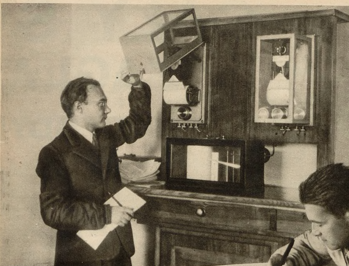
Dyżurny meteorolog dokonywa zmiany pasków dobowych na aparatach elektrycznych, rejestrujących kierunek i siłę wiatru.
