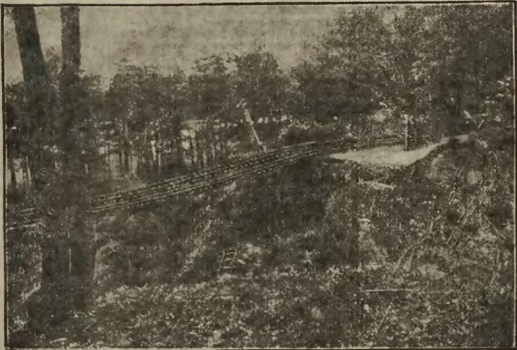
Wie eine Brücke hängen die Eisenbahnschienen über der Tiefe des Trichters
