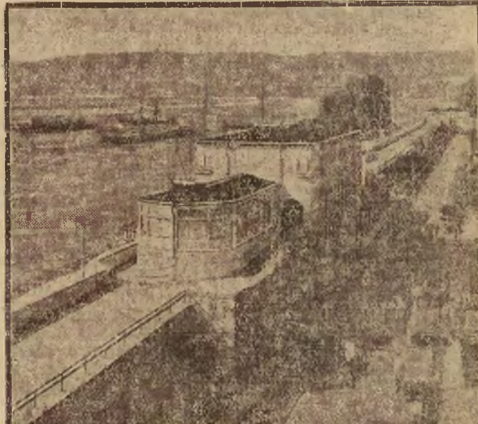
Deichanlage gegen Rheinüberschwemmungen in Neuwied a. Rh. die zum Schutz der Stadt vor Ueberschwemmungen des Unter Rheins errichtet wurde; sie zählt zu den modernsten Anlagen in Deutschland
