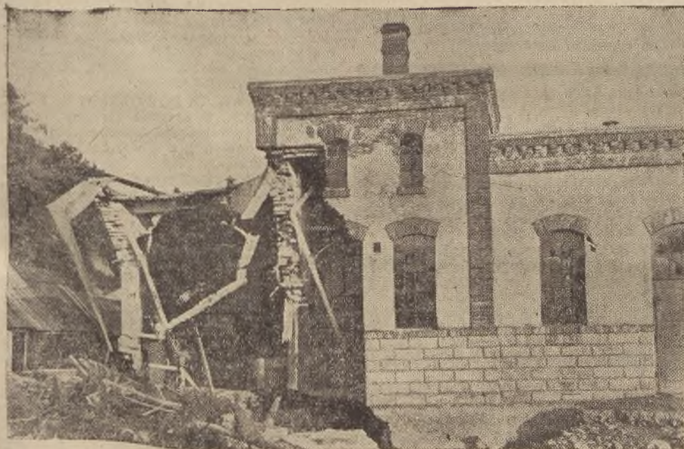
Rzeźnia miejska w Mszanie Dolnej, zniszczona przez wylew Raby.
