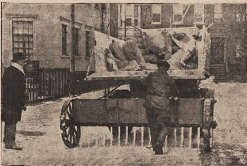
Nowy sposób oczyszczania ullic ze śniegu i lodu przez posypywanie bruku proszkiem.
