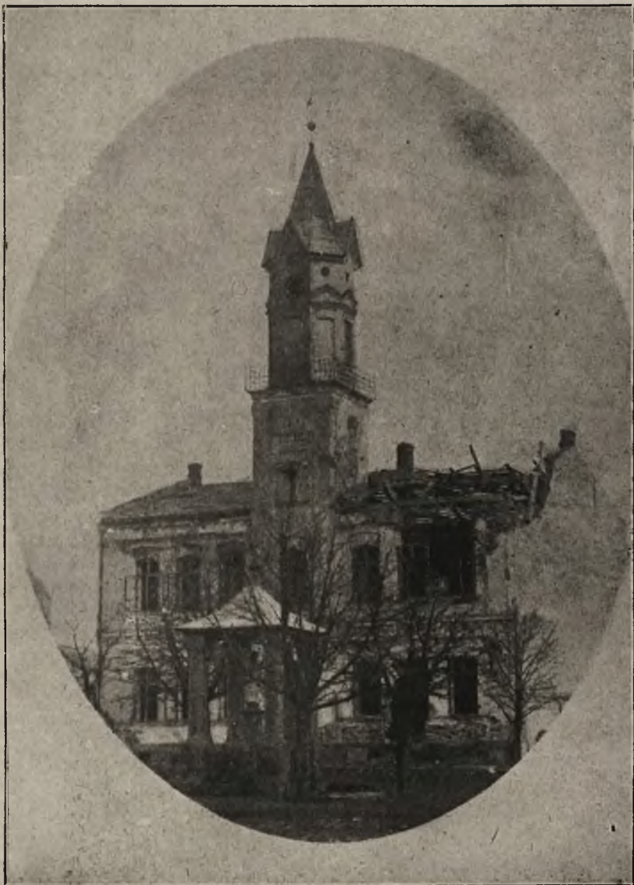
Uszkodzona szkoła w Kołaczycach koło Jasła.
