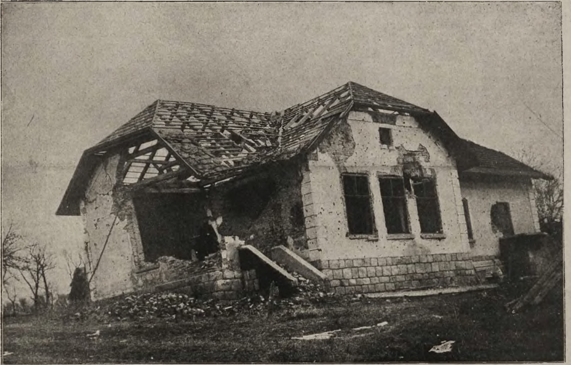
W rocznicę przełamania frontu rosyjskiego: Zburzona szkoła w Staszówce pod Gorlicami.
