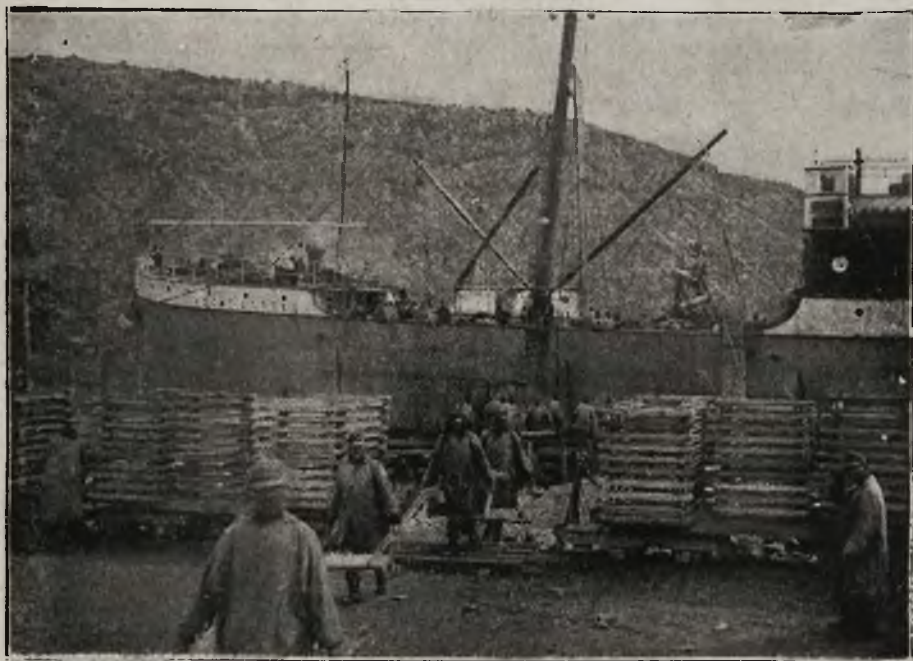
Wyładowywanie materiałów do budowy kolejki.
