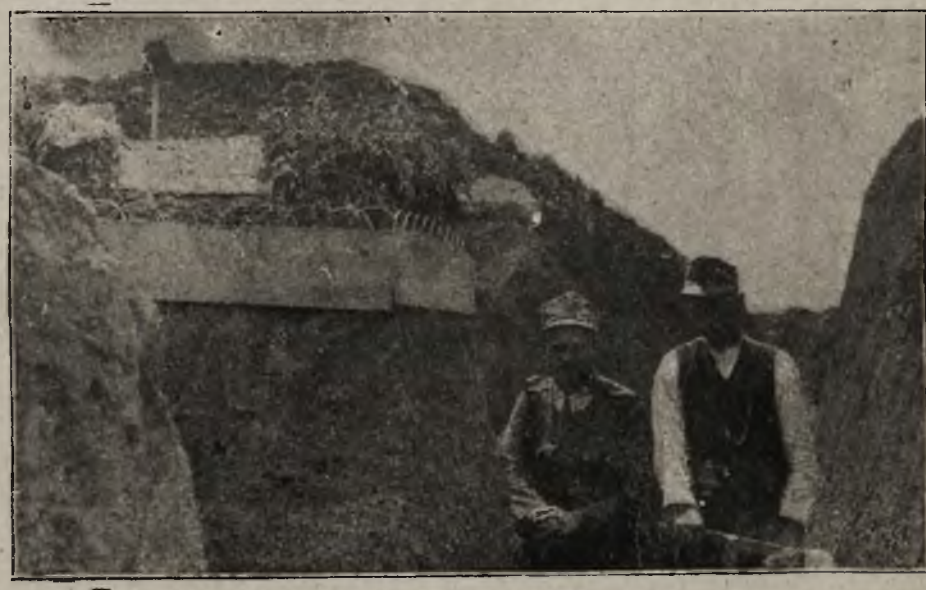
Na wschodnim froncie: Budowa nowych schronisk dla oficerów pułku piechoty.
