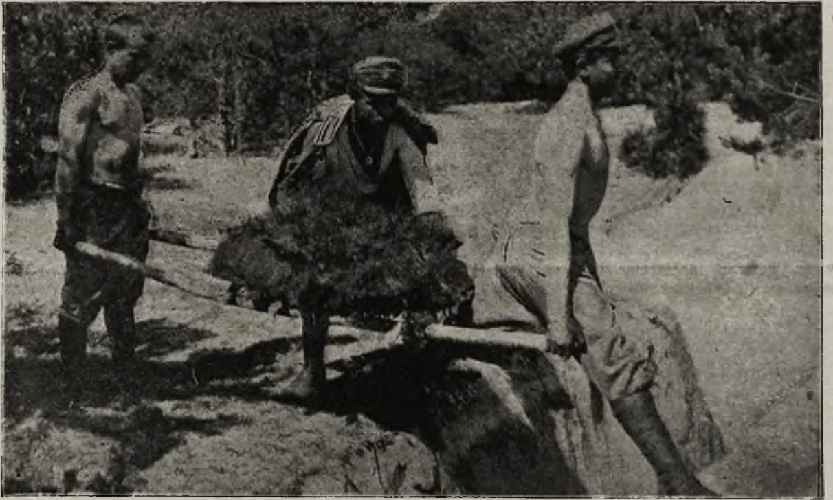
Legiony na polu walki: Przy budowie nowych okopów.
