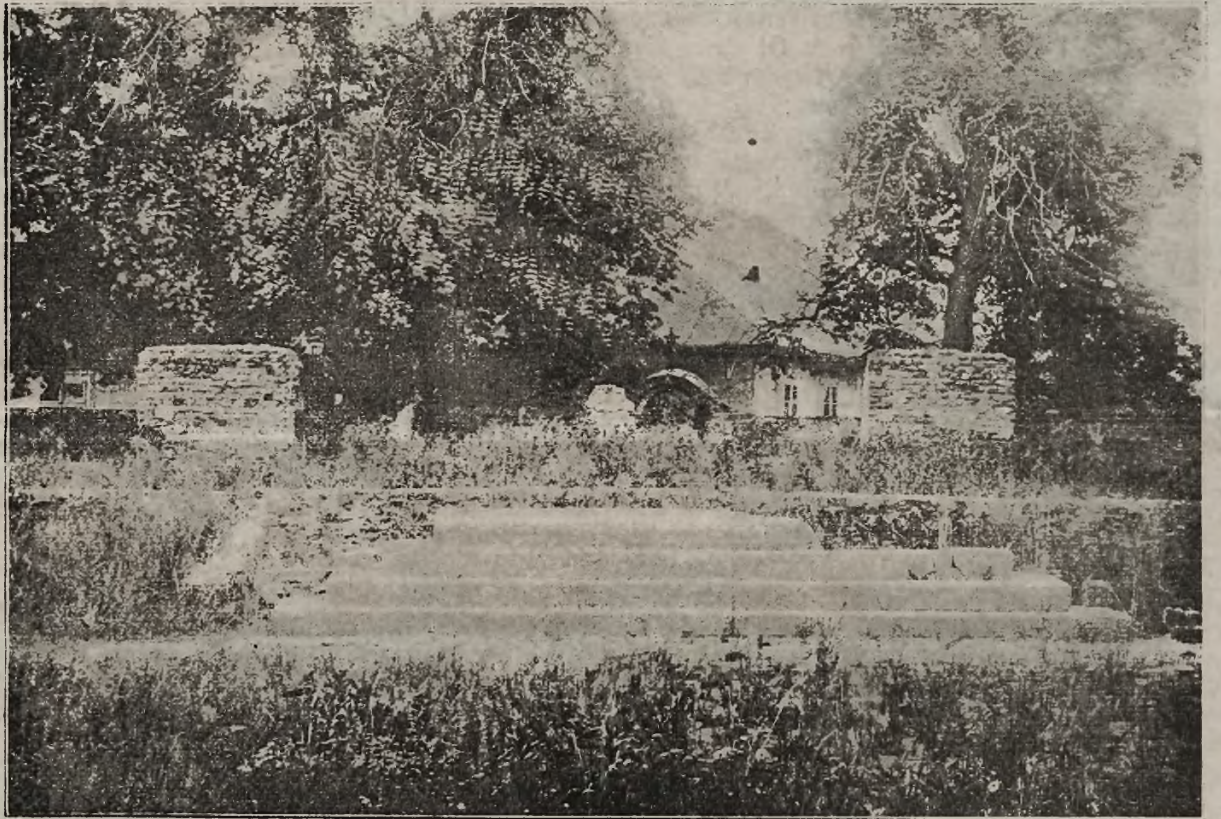
Z pobojuwiska w Rudniku nad Sanem: Ruiny spalonego kościoła parafialnego.
