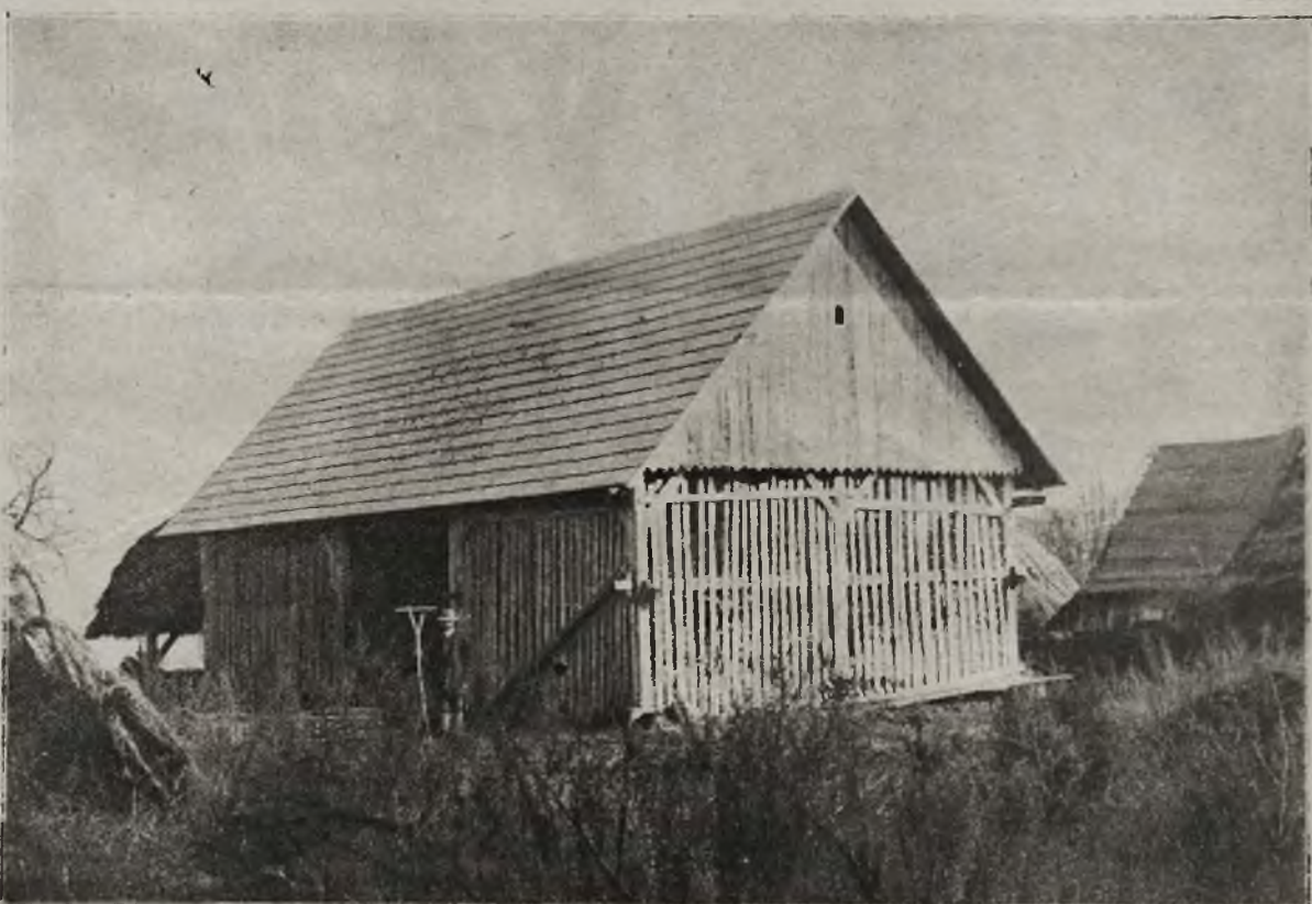
Z odbudowy Galicyi: Odbudowana stodoła włościańska w Tarnawach (pow. przemyski), kryta dachówką cementową.
