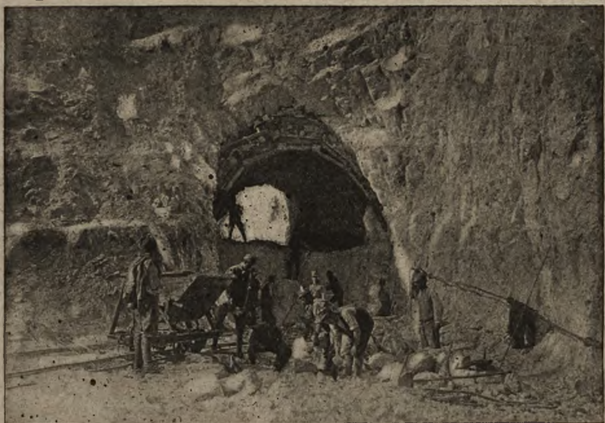
Z włoskiego frontu: Budowa drogi w górach alpejskich na froncie tyrolskim.
