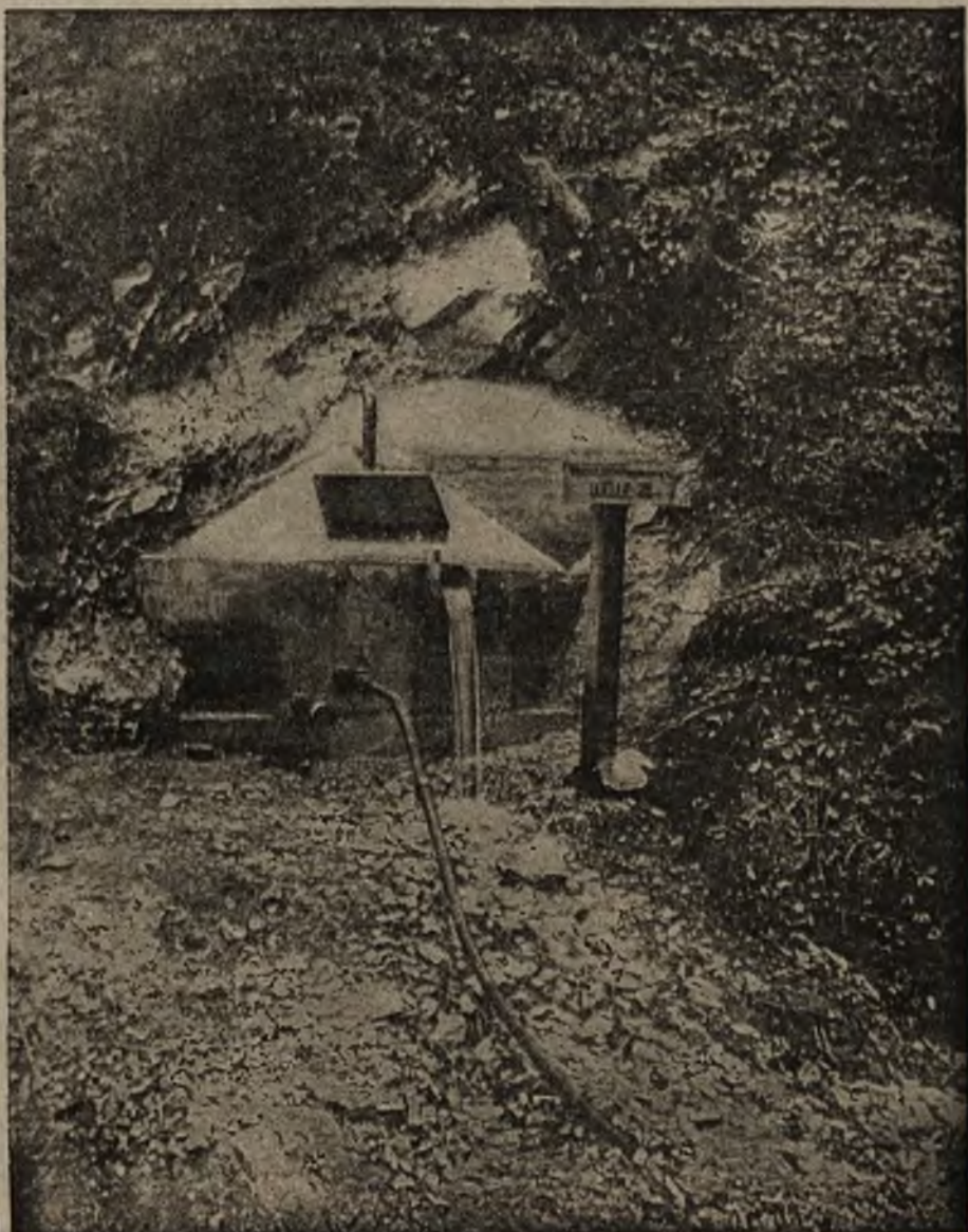
Z wprostego źródła: Źródło w górach, ujęte w zbiornik, z którego woda płynie rurami do okopów.
