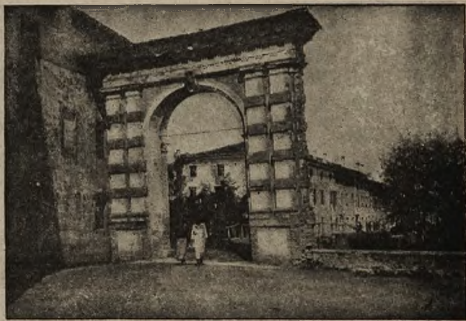
Z wielkiego frontu: Łuk tryumfalny z IX. stulecia w Sesto (Wenecja) (Fot. K. Schaller)
