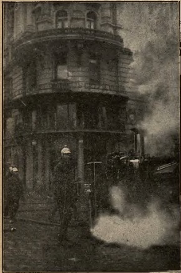
Pożar w warszawskim hotelu „Bristol”: Sikawka parowa tłoczy wodę na 7 piętro.
