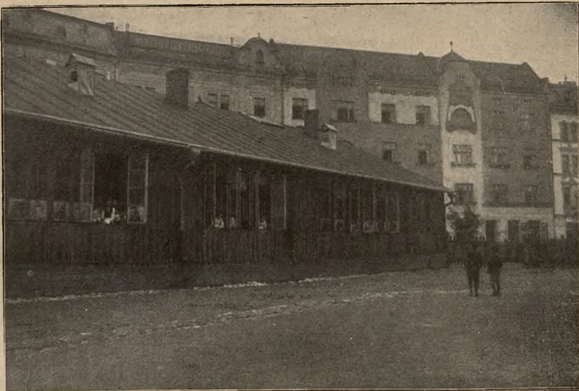
Uzupełnienie armii: Lokal asenterunkowy w szkole przy ul. Dietlowskiej w Krakowie.
