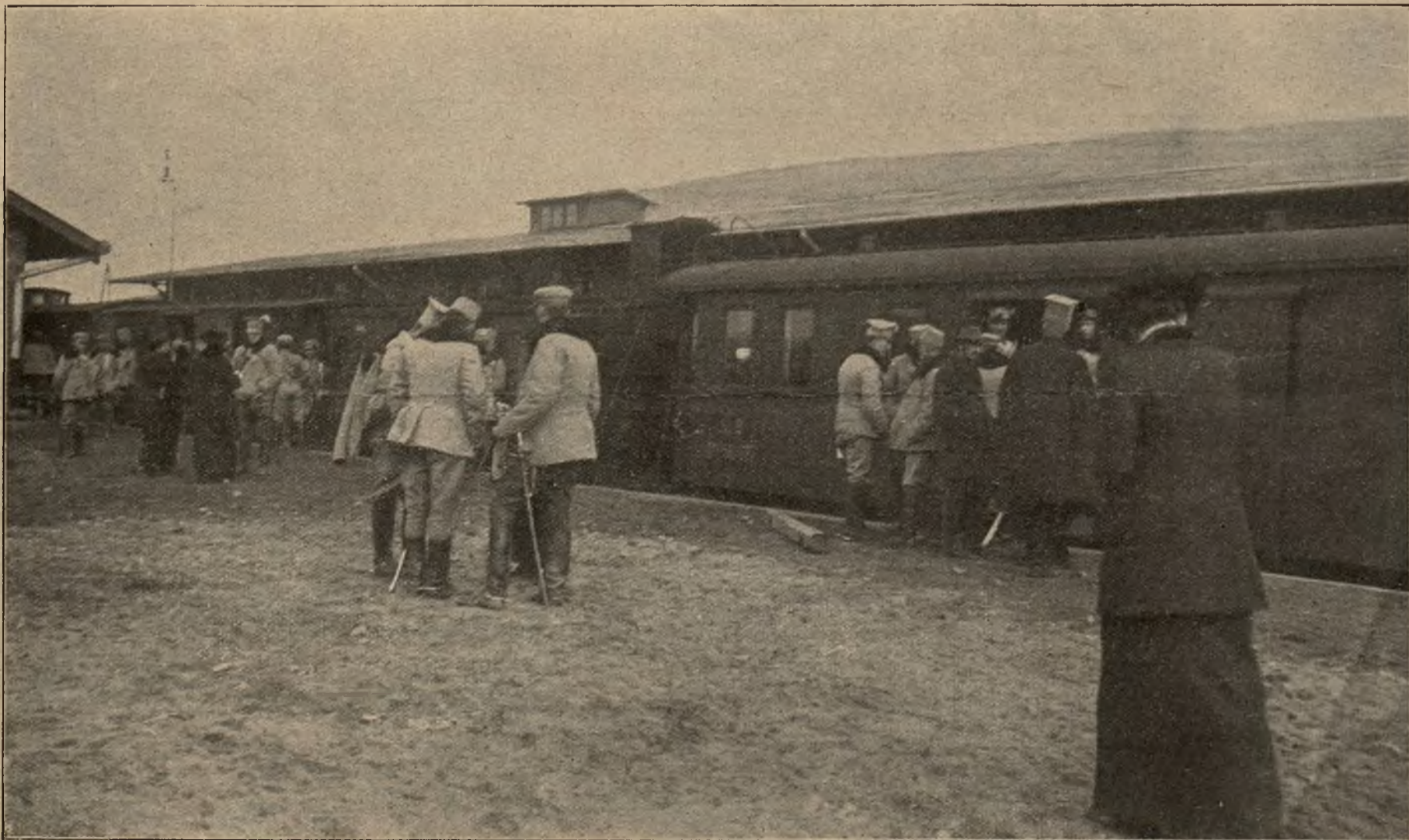
Na pole walki: Odjazd konnych Legionistów z dworca towarowego w Krakowie.
