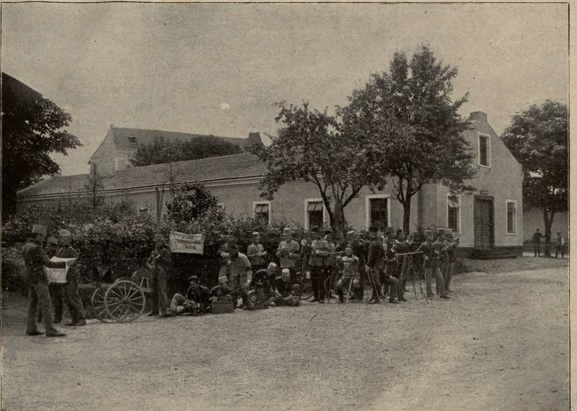
Na łądzie, w wodzie i w powietrzu: Stacja austriackiego telegrafu polowego.
