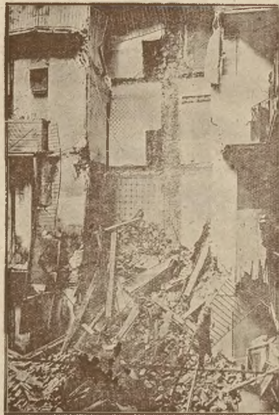
We Lwowie przy ul. Skarórowskiej runęła kamienica, pozabawiając 100 osób dachu nad głową. Wypadki walenia się kamienic stają się coraz częstsze. Odmów nowych nie buduje się, stare się wałają, kłęska mieszkaniowa zaognia się. Co na to rząd?.. Fot. M. Miinz
