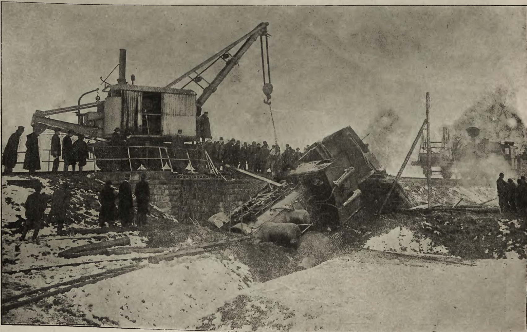
Znowu katastrofa kolejowa: Dźwignie parowe („hebery“) przy pracy ratunkowej.
