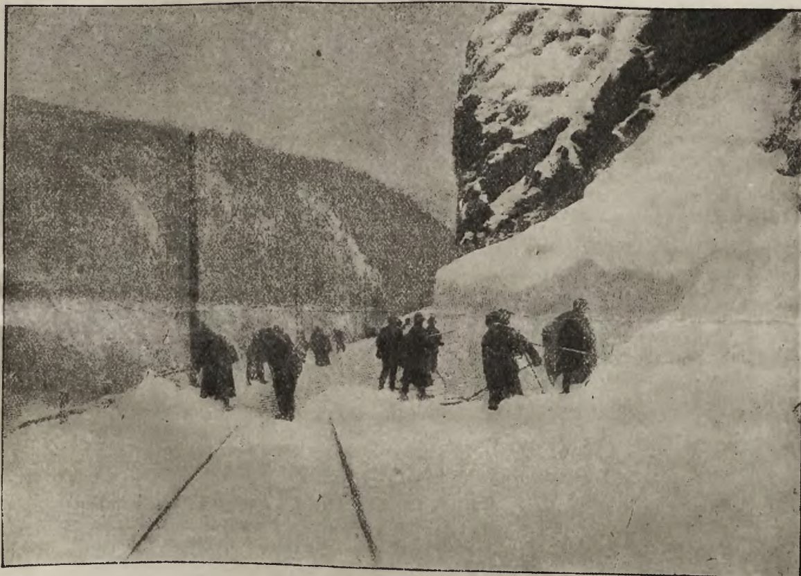
Zasypani śniegiem: Praca nad oczyszczeniem ze śniegu toru kolejowego.
