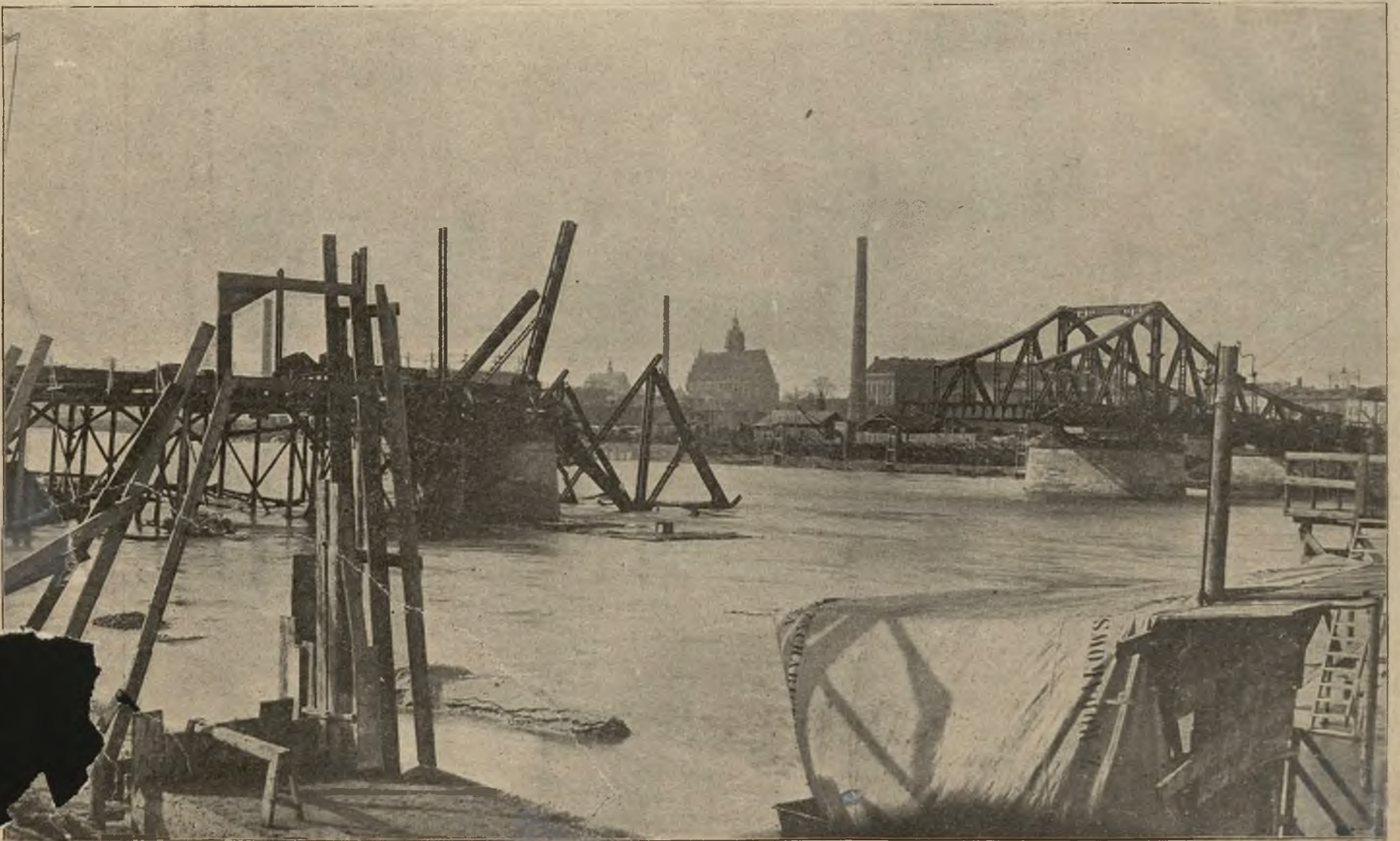
Zawalenie się mostu w Krakowie: Widok zawalonego mostu od strony Podgórze.
