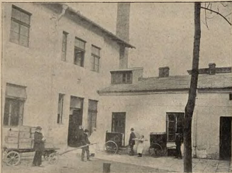
Widok ogólny fabryki.
