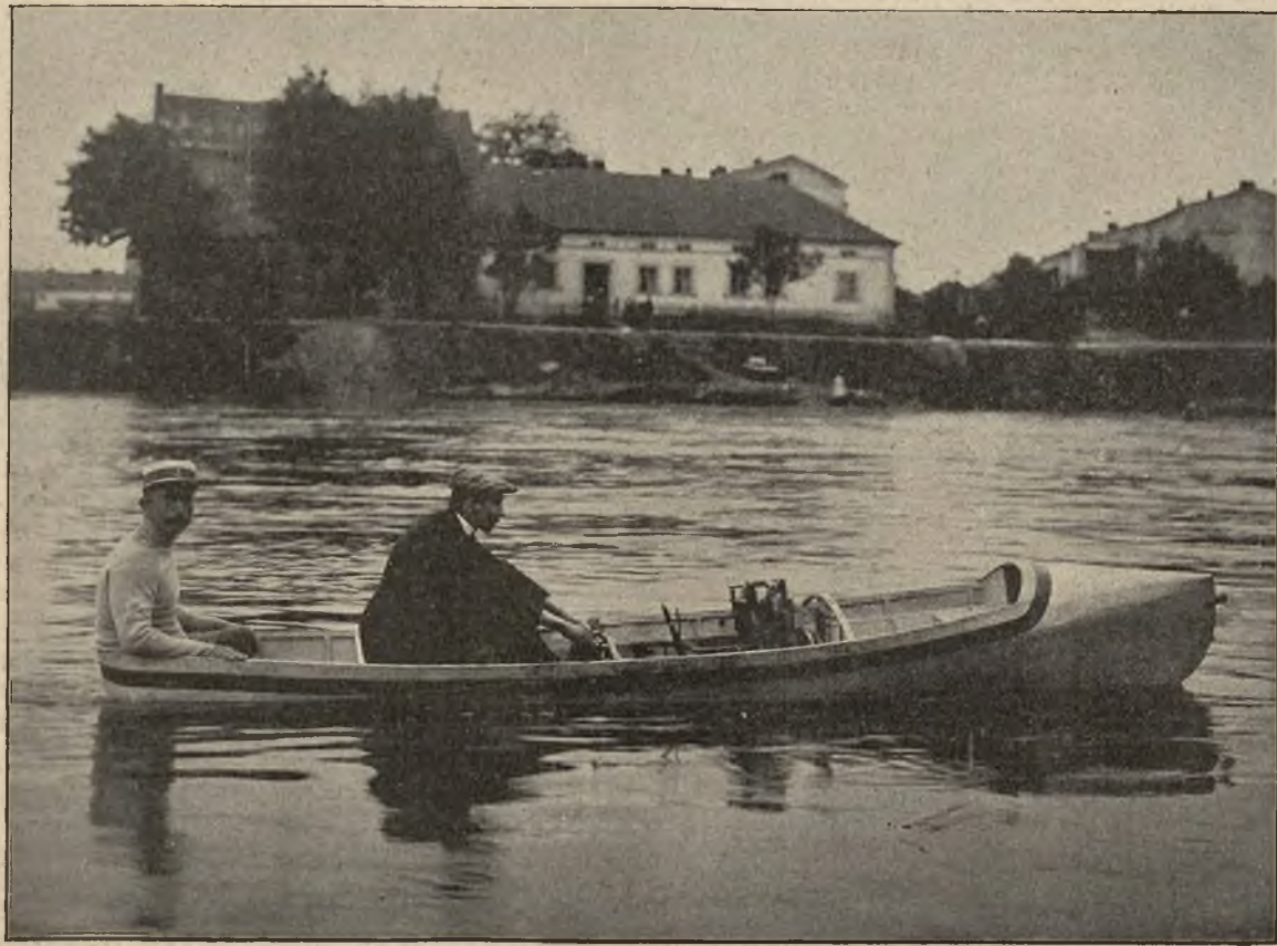
Łódź motorowa pomysłu Krakowianina: Łódź motorowa konstrukcyi mechanika Bisztygi na falach Wisły pod Krakowem
