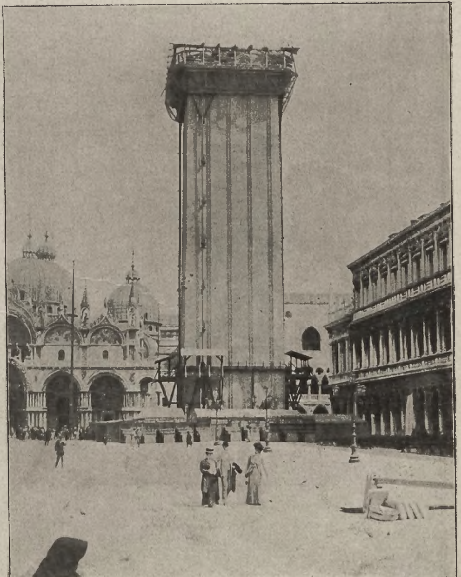
Ocalone areydzioło budownictwa: Odbudowa dzwonnicy kościoła św. Marka w Wenecji w obecnym stadium.
