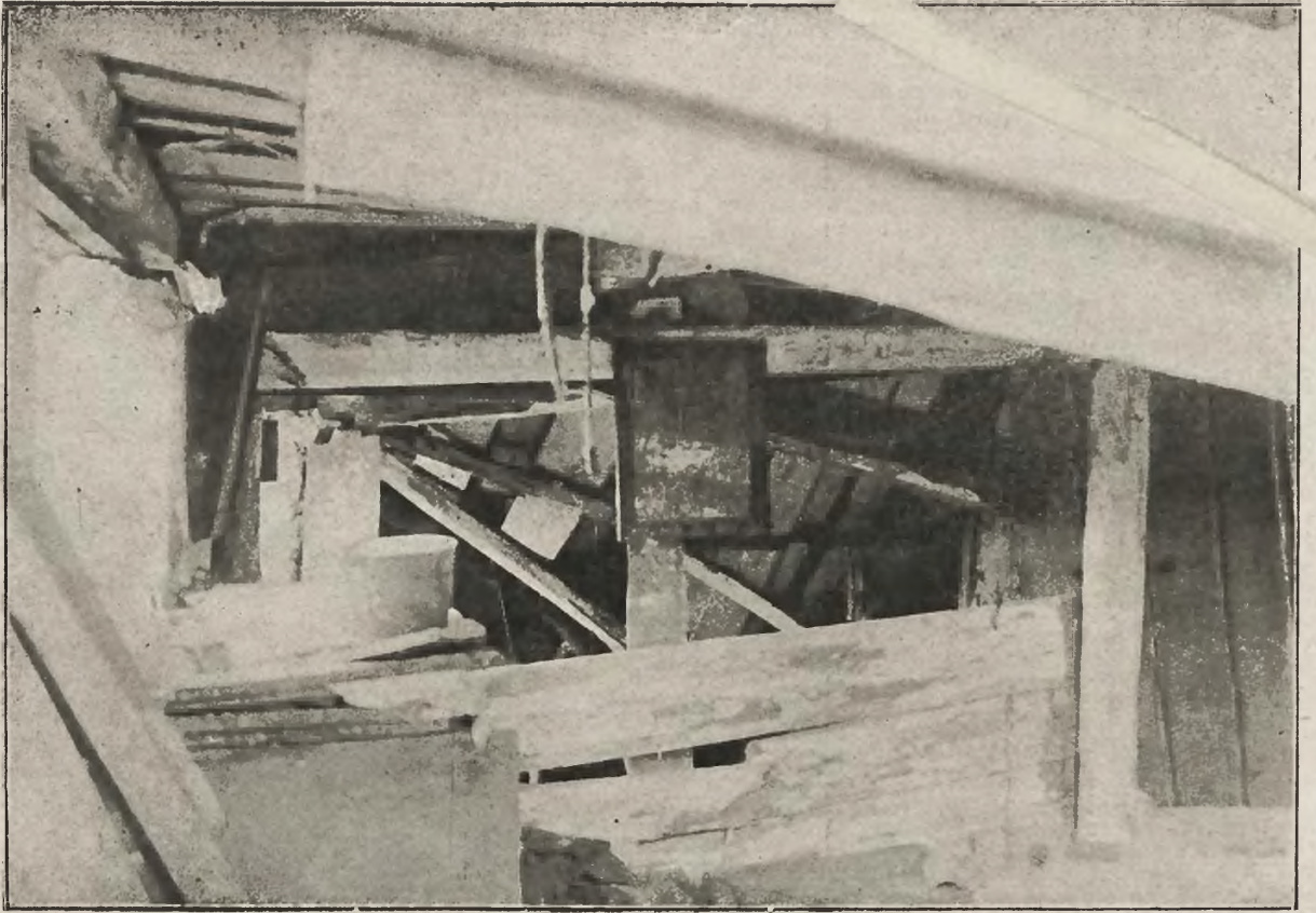
Po wybuchu prochowni: Wnętrze domu Kopców, zdemolowane przez wybuch.
