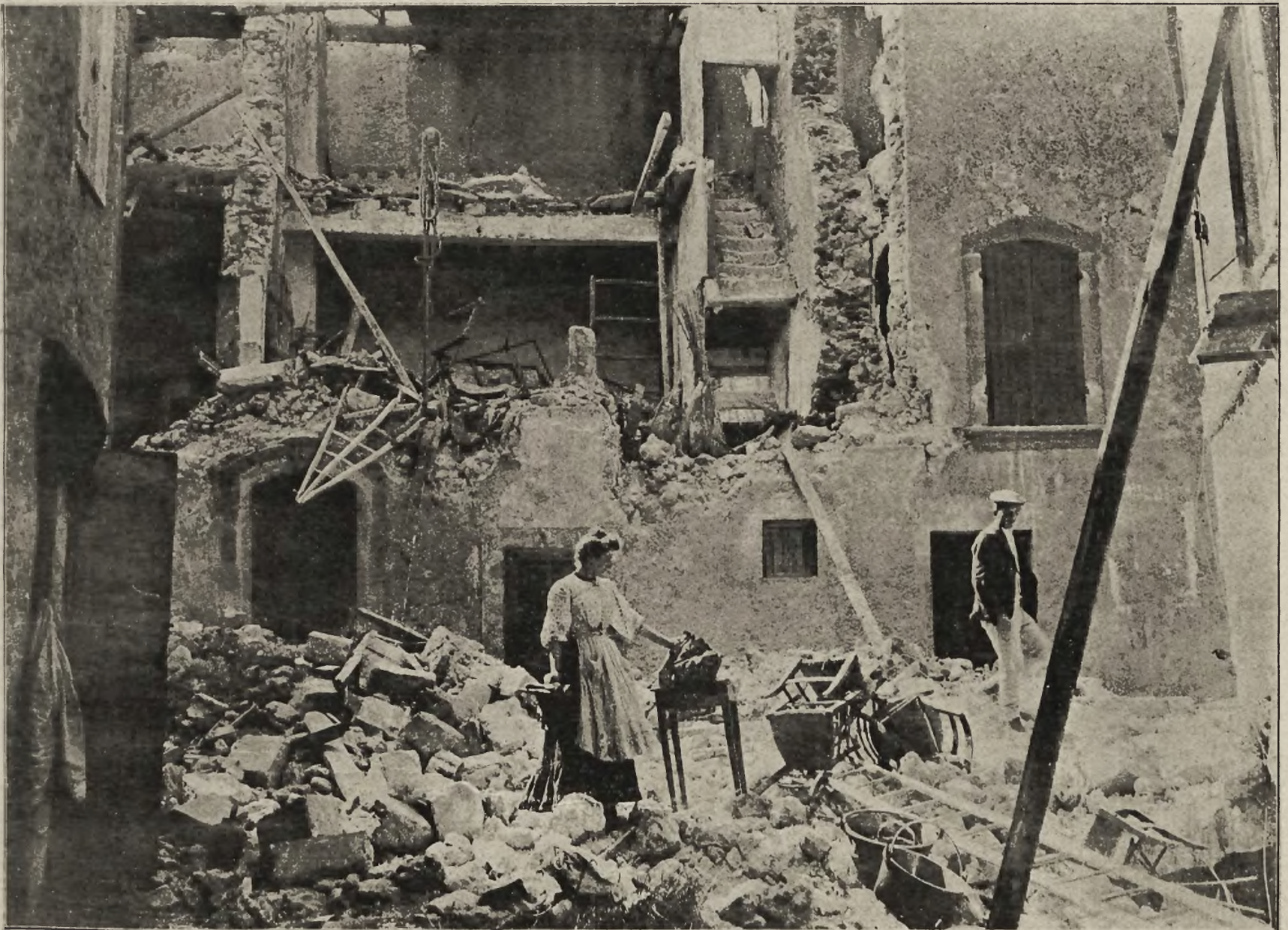
Trzęsienie ziemi w południowej Francji: Wnętrze jednego z zawalonych domów.
