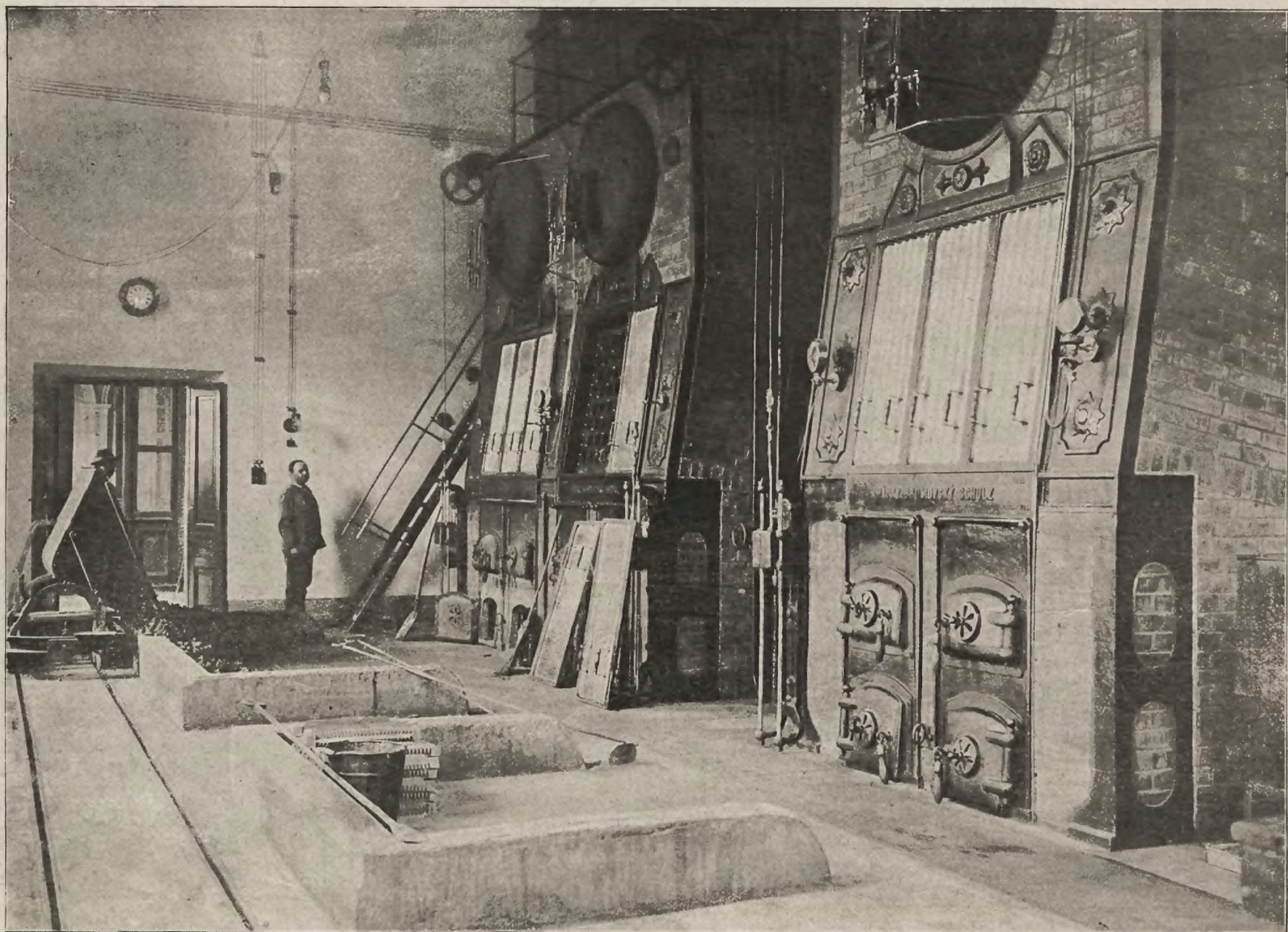
Wycieczka do Wodociągu: Kotłownia obok hali maszyn zakładu wodociągowego w Bielarach.
