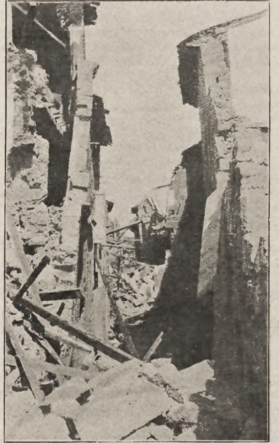
Trzęsienie ziemi w południowej Francji: Ulica w mieście Vernegues.
