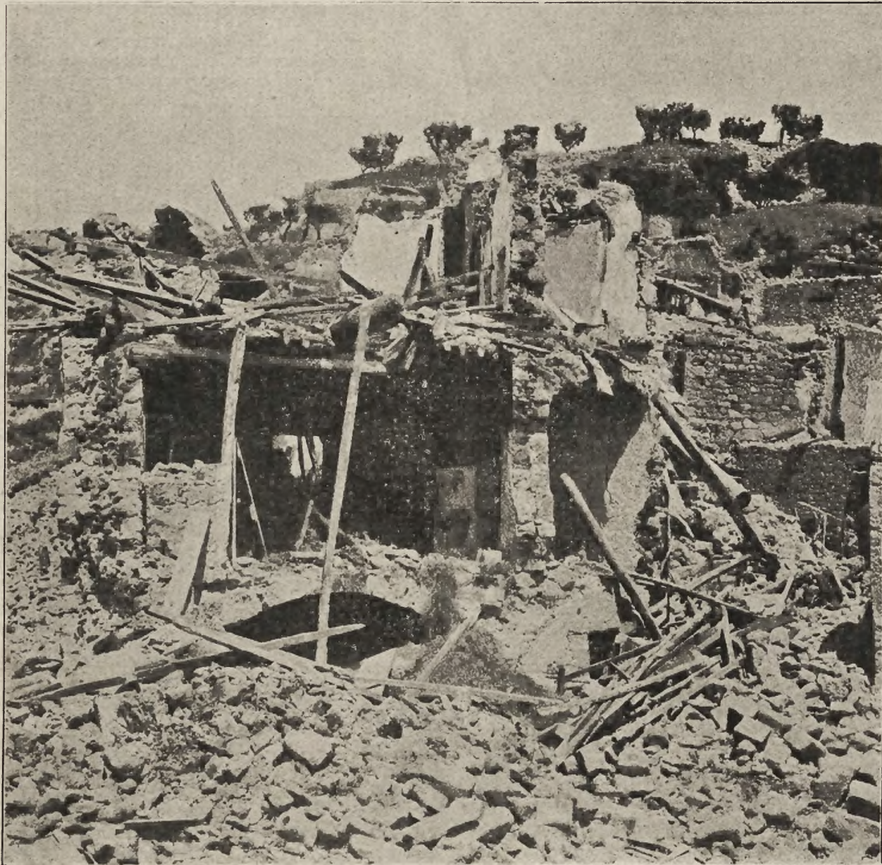
Trzęsienie ziemi w południowej Francji: Widok domu w Rognes, zrujnowanego skutkiem trzęsienia ziemi.
