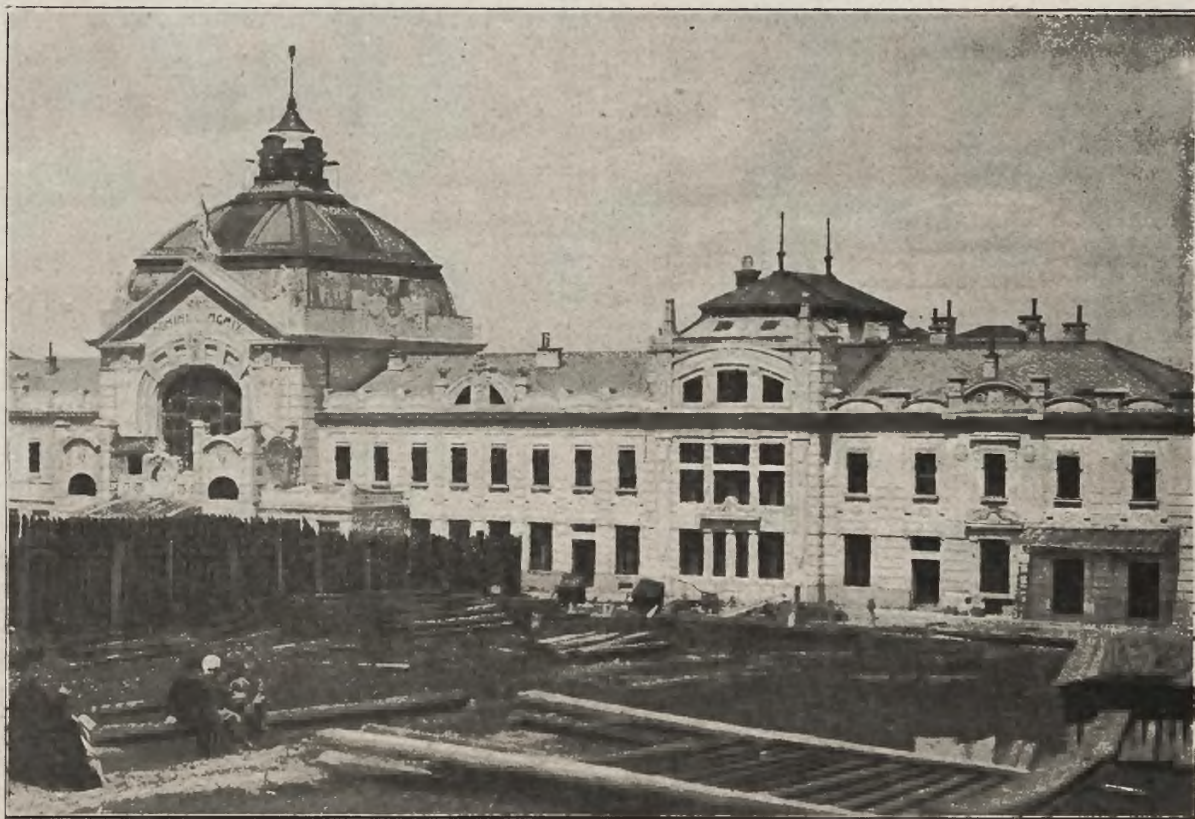
Nowy dworzec w Czerniowcach: Widok ogólny nowego dworca kolejowego w Czerniowcach.
