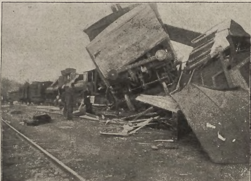
Katastrofa kolejowa w Podwysokim: Grupa rozbitych wozów na miejscu wypadku.
