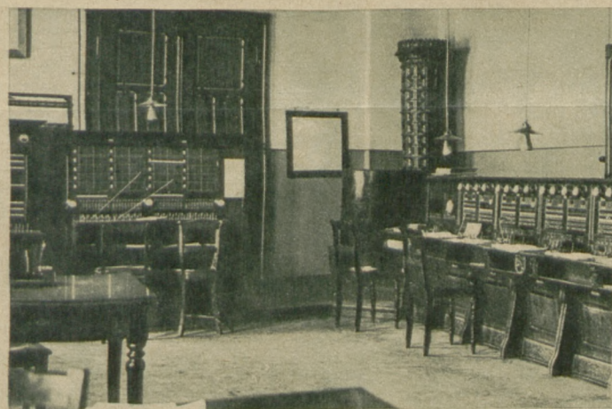
Im alten Fernamt; links ein Klittenumschalter, rechts ein Teil der Fernschränke
