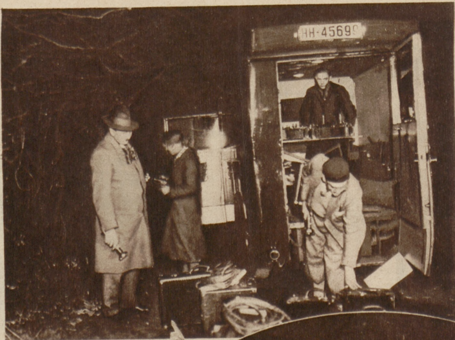
Die Techniker an der Arbeit: Kabel werden ausgelegt
