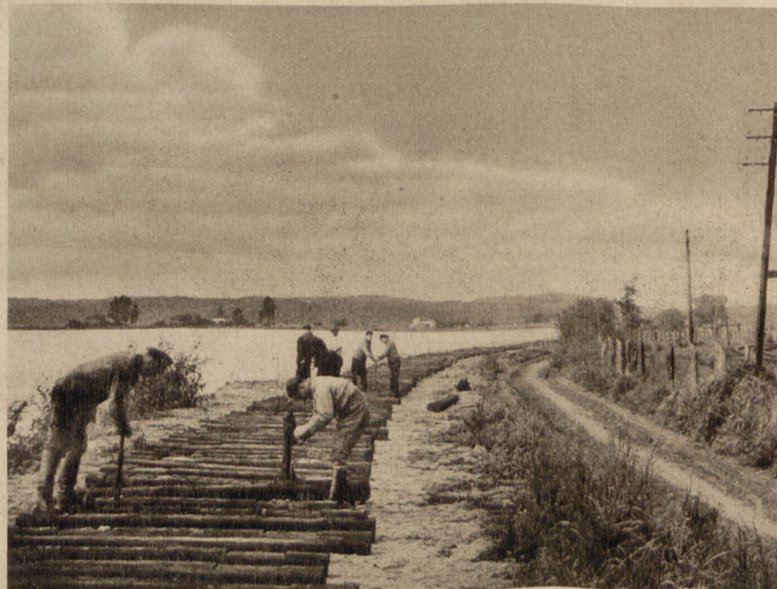
Hier werden die Bohlen für die Feldbahn gelegt Erst mit deren Hilfe können die Sandmassen fortgeschafft werden
