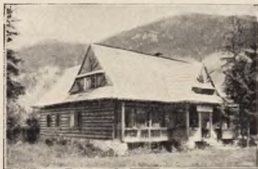
Schronisko PTT w Roztoce przed przebudową
