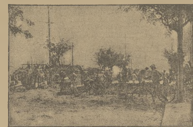
Żołnierze chińscy naprawiają drogi zniszczone przez bomby japońskie.
