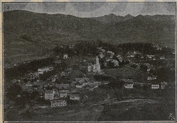
Szczawnica. Widok ogólny.
