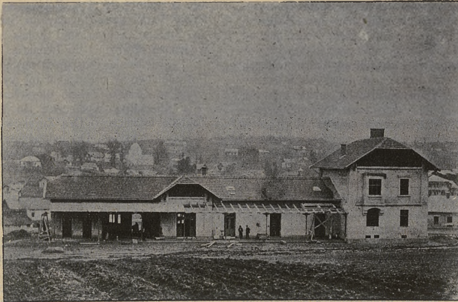
Truskawiec: Dworzec kolejowy.
