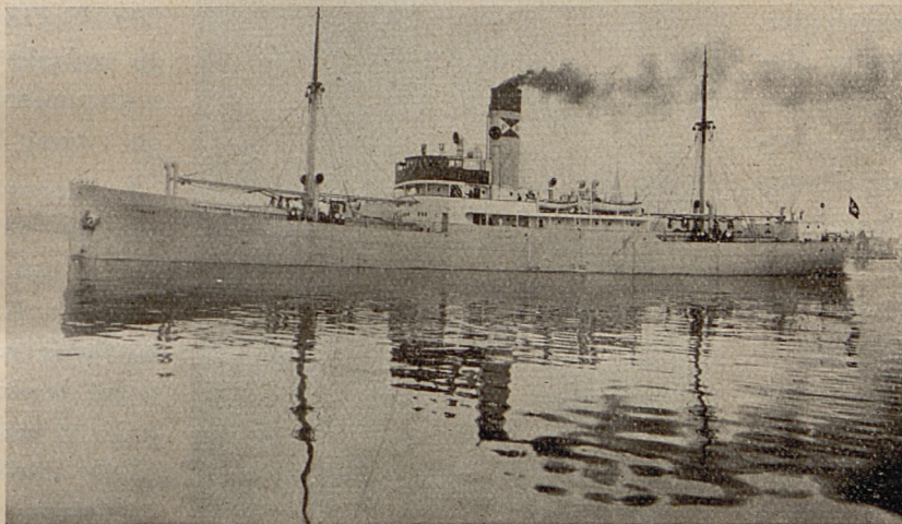
„Lublin”, nowy statek Polsko Brytyjskiego Towarzystwa Okrętowego wyposażony w specjalne urządzenia chłodnicze dla przewozu bekonów i innych produktów wymagających chłodzenia.
