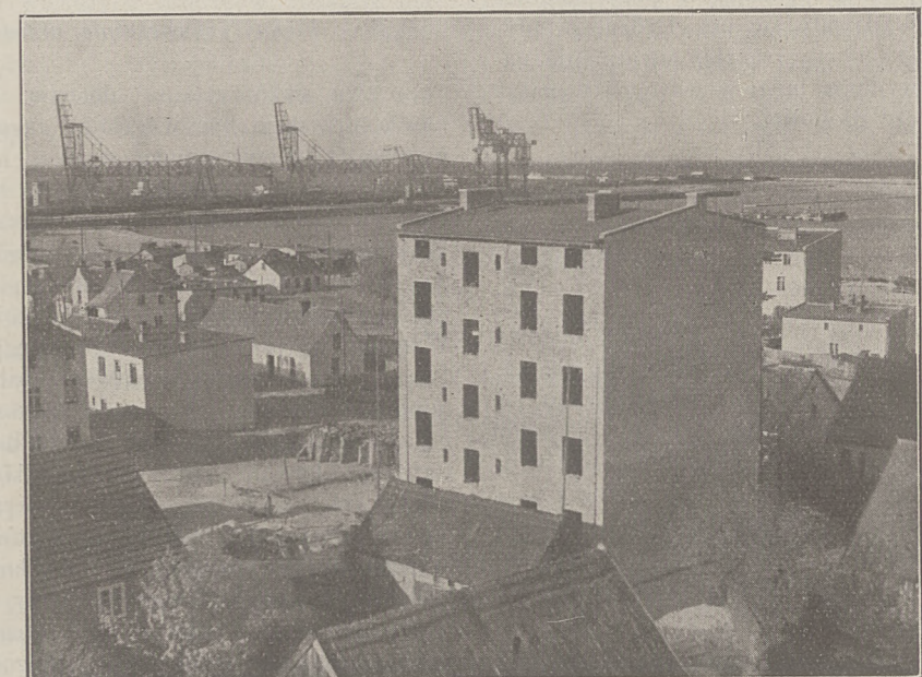
Charakterystyczny fragment z Gdyni: budująca się wielka kamienica, obok zaś chałupy, kryte słomą. W oddali widać część portu.
