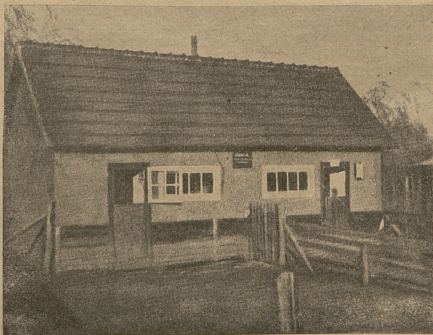
Chlew z prasowanej słomy, dwukłatkowy, o ścianach wyprawionych gliną.
