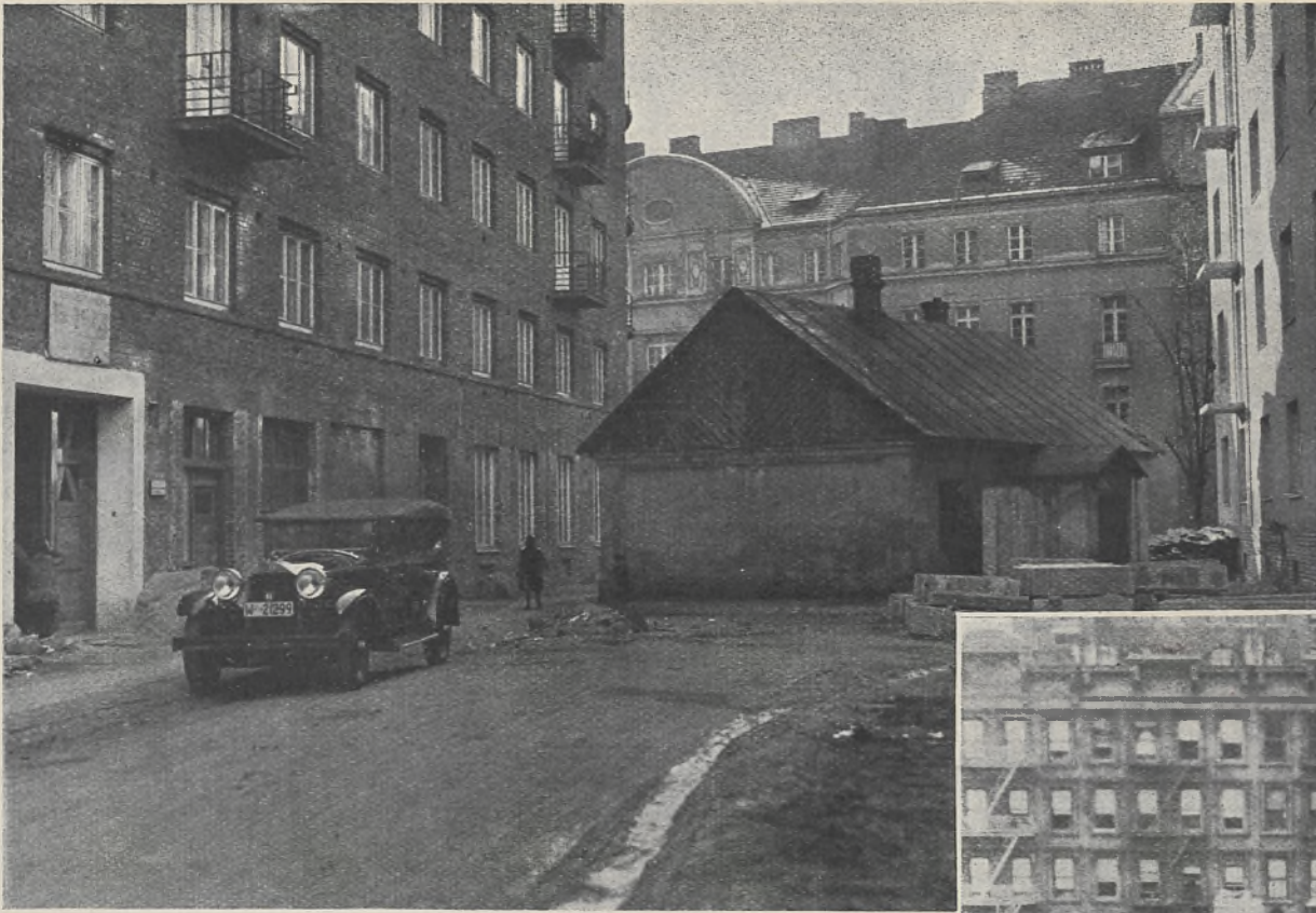
Wśród nowoczesnych budowli na peryferjach naszej stolicy pozostały stare domki-rudery.
