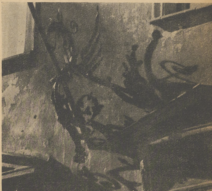
Ozdobnik z kutego żelaza nad bramą domu przy Placu Nankiera 7
